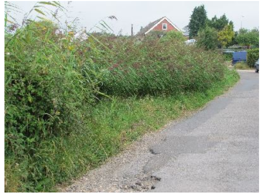
Road edge trimmed
